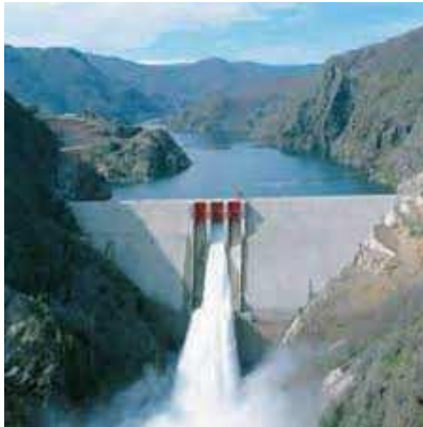
Vista Central Hidroeléctrica Ralco
