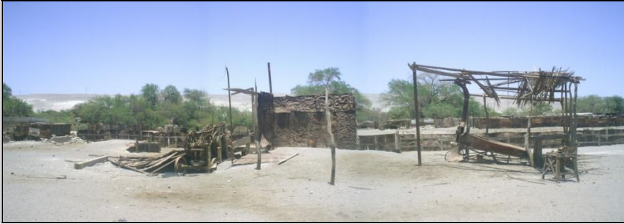
Estado de la antigua Cooperativa Agrícola de Quillagua (2007).
